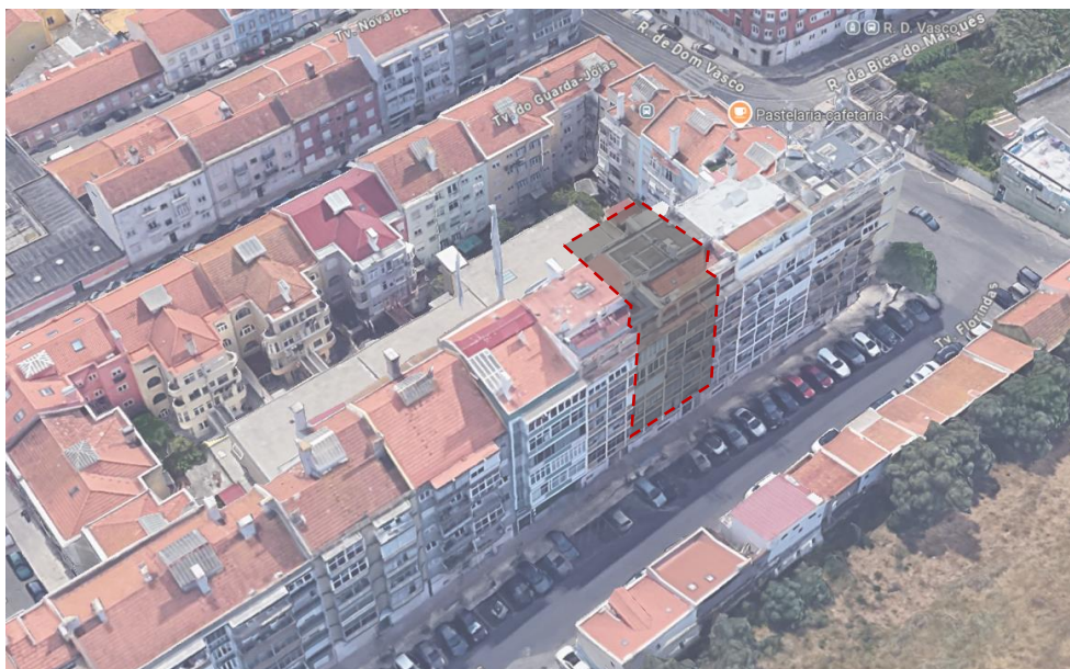
Figura 1 – Identificação do edifício alvo de intervenção
